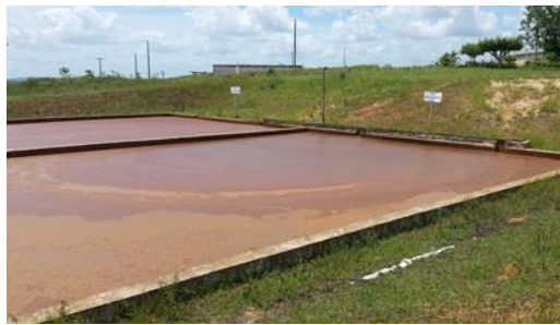
Figura 3.11: Leito de secagem da ETA – SAJ. Fonte: Menezes, 2015.
