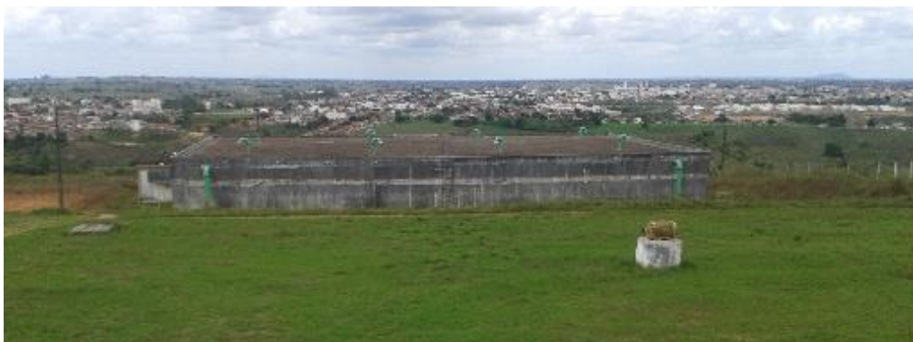
Figura 3.8: Reservatório de água tratada onde se realiza a desinfecção da água.
