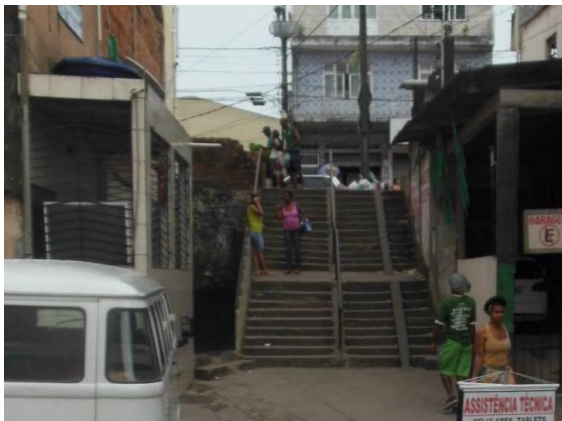
Figura 5.11 - Escadas drenantes no local chamado Baixa Fria.
