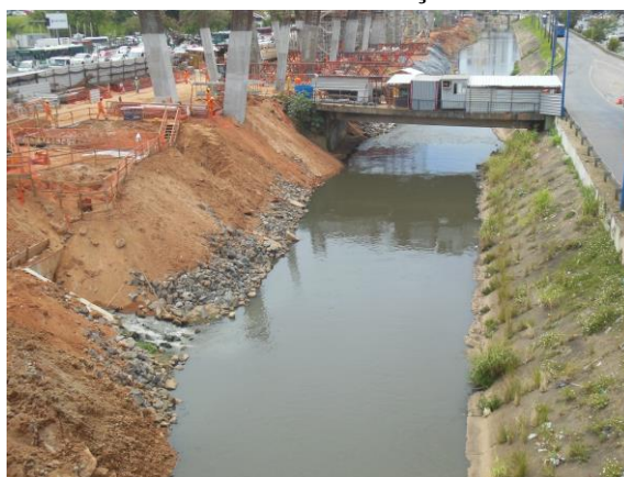
Figura 5.26 –Aterramento de partes do rio, com a obra da construção do metrô.
