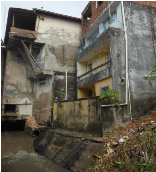
Figura 5.15 - Tubulações de contribuição pluvial e de esgoto.
