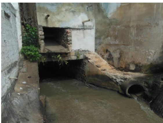
Figura 5.13 – Início do Trecho 2, Rua da Saboaria.
