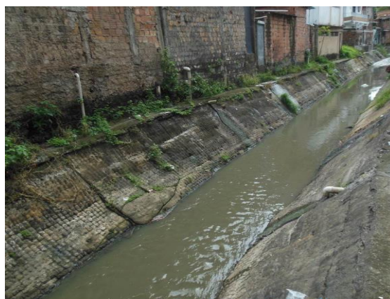
Figura 5.14 - Canalização do córrego.
