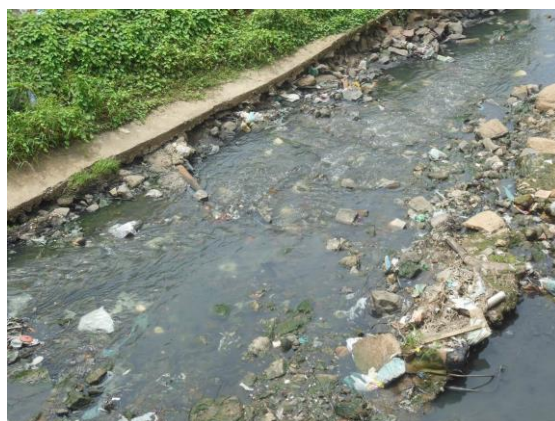
Figura 5.33 - Resíduos sólidos ao longo do canal no Trecho 5.
