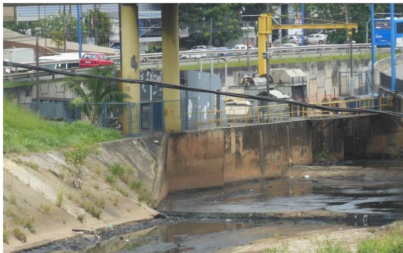
Figura 5.28 - Unidade de Captação em Tempo Seco.
