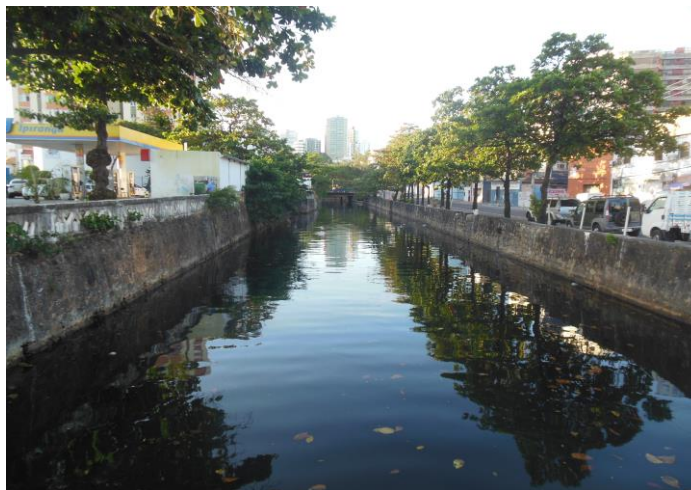
Figura 5.40 - Canal revestido com pedra argamassada e com seção retangular.
