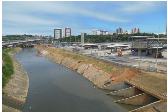
Figura 5.23 - Trecho 4, totalmente canalizado com margens de concreto.
