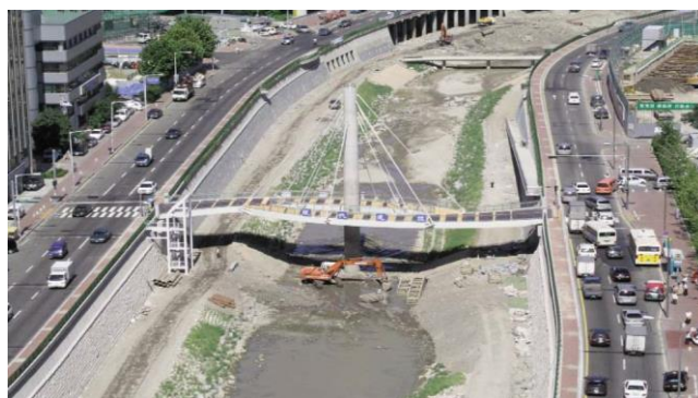
Figura 3.7 - Demolição das estruturas de concreto.
