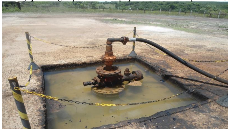
Figura 5.7 -Injeção da água produzida no poço desativado (Próprio autor).
