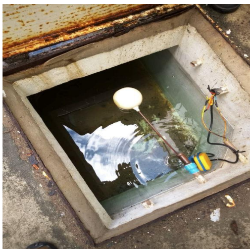
Figura 3: Acumulação de matéria orgânica no fundo do reservatório - 2018
