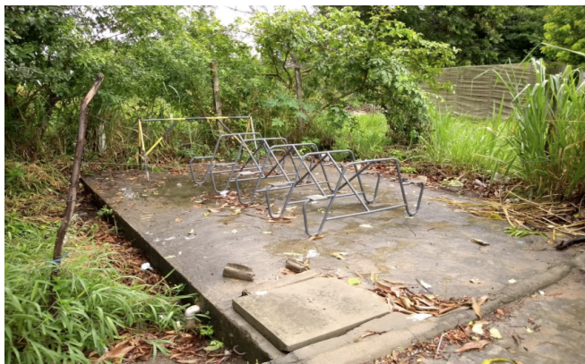
Figura 4: Reservatório de distribuição inferior– unidade garagem/oficina – 2018
