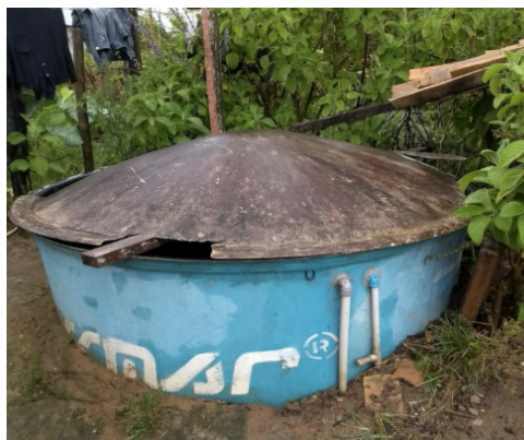
Figura 18: Reservatório parcialmente enterrado e sem vedação suficiente – 2018
