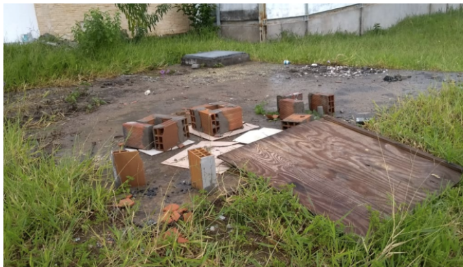
Figura 16: Reservatório predial inferior - pavilhão de engenharias - 2018
