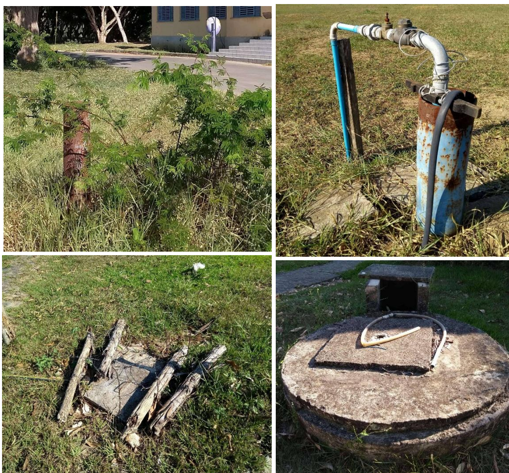
Figura 7 - Situação dos poços em estudo
