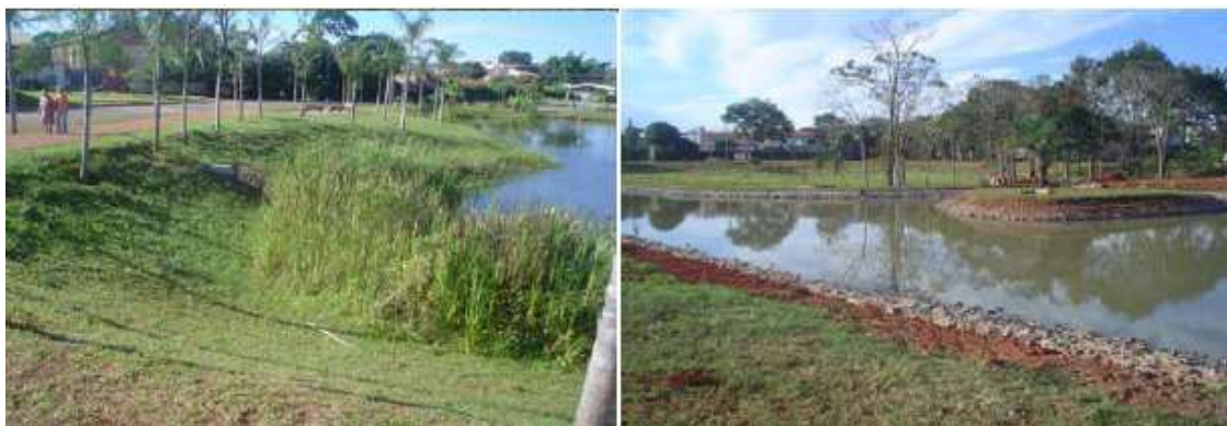
Figura 3-18– Bacias de retenção implantadas em praças do setor Jaó – Goiânia/ GO
