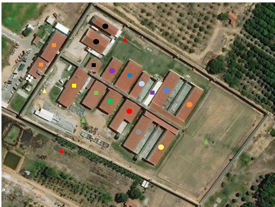
Figura 8 – Estrutura física da Penitenciária Dr. Edvaldo Gomes, Petrolina – PE, 2021.
