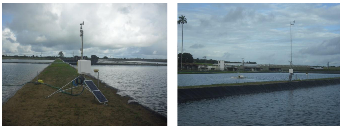
Figura 2 - Instalação de torre meteorológica com anemômetro a 3 m de altura (esquerda) e a 7 m de altura (direita) no ano de 2015, onde se vê também a plataforma flutuante no centro do espelho d'água.
