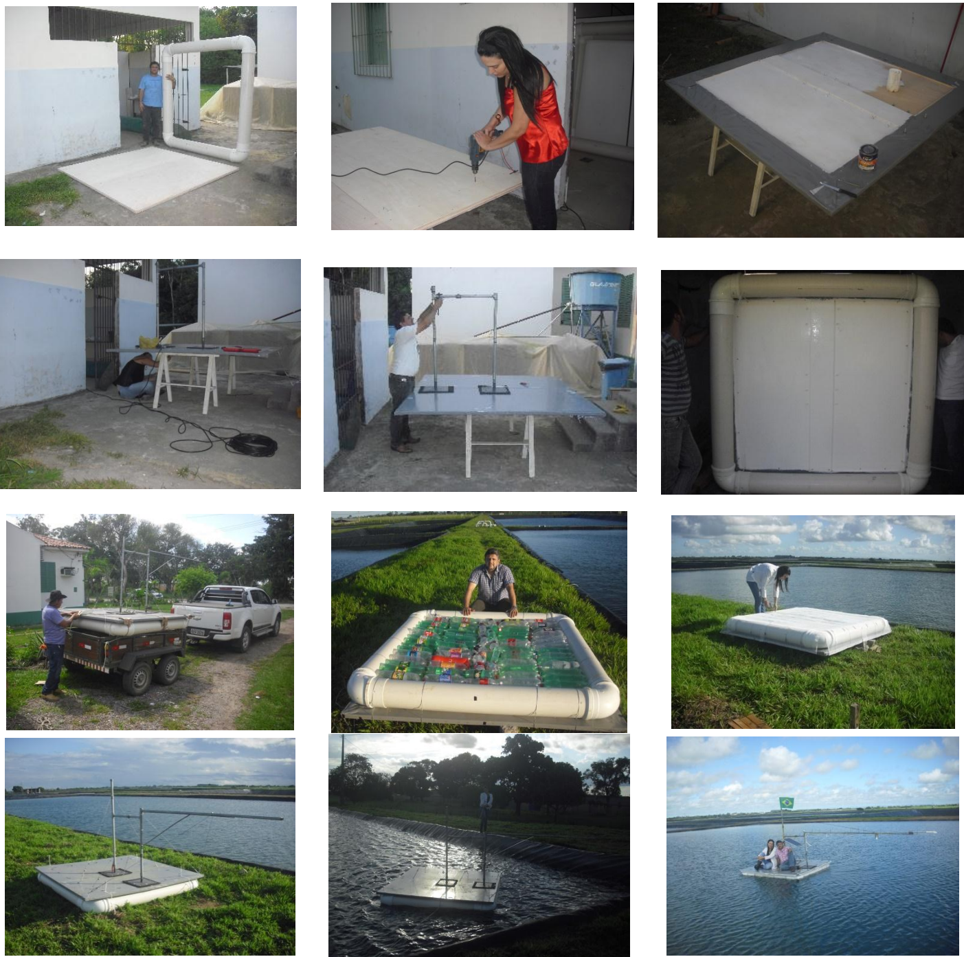
Figura 5 - Desenvolvimento e instalação da primeira plataforma flutuante de baixo custo para montagem dos sensores no reservatório experimental.
