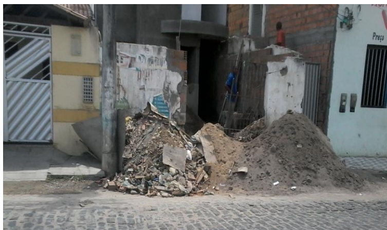
Figura 4.6 - RCD depositado em calçada de Cruz das Almas
