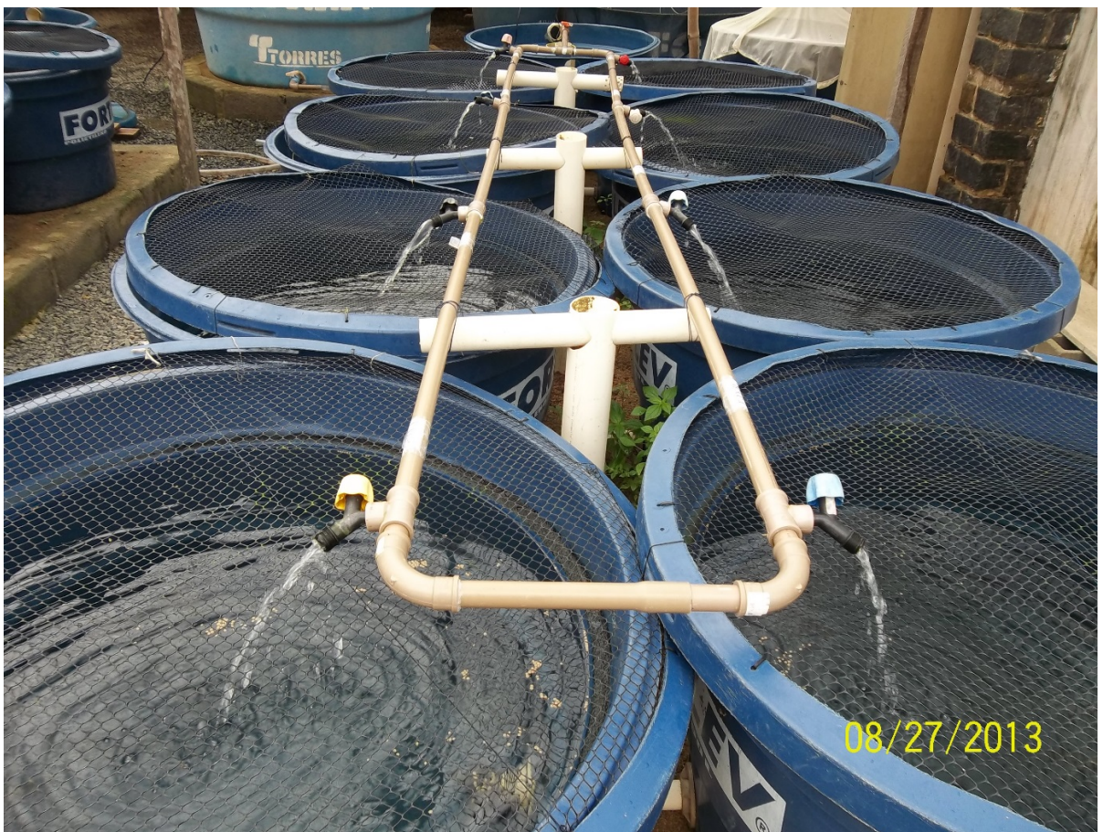
Figura 4. Vista da estrutura hidráulica de circulação de água
