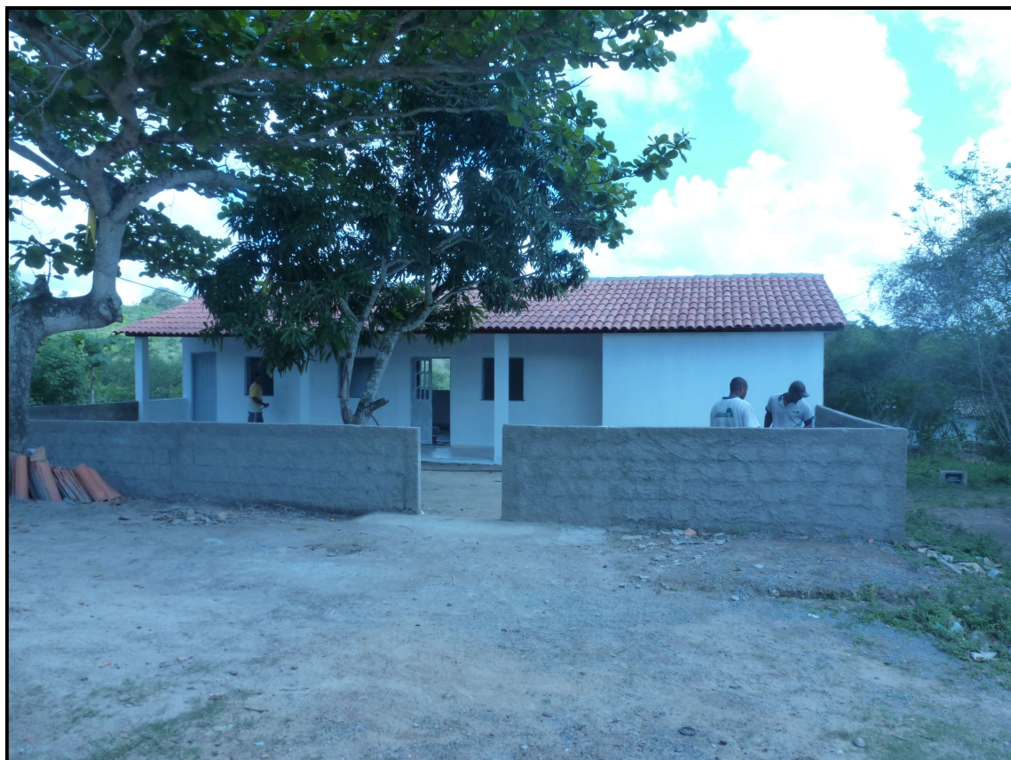
Figura 07. Creche Comunidade Quilombola da Linha em fase de acabamento. 04/2015
