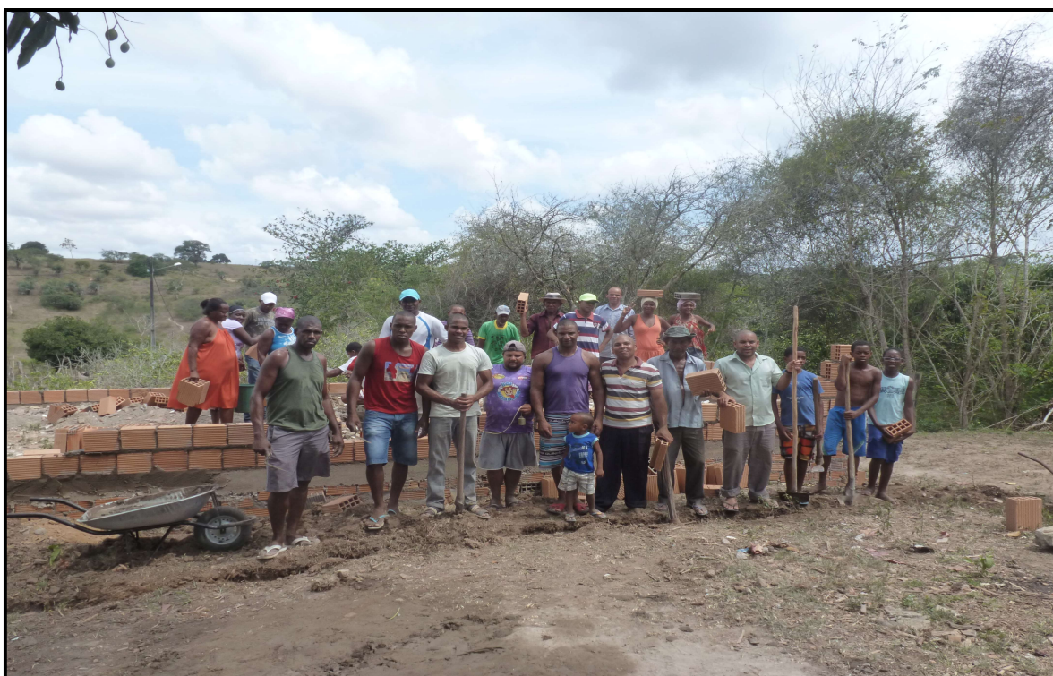
Figura 04. Mutirão construção da Creche Comunidade Quilombola da Linha. fevereiro/2015.
