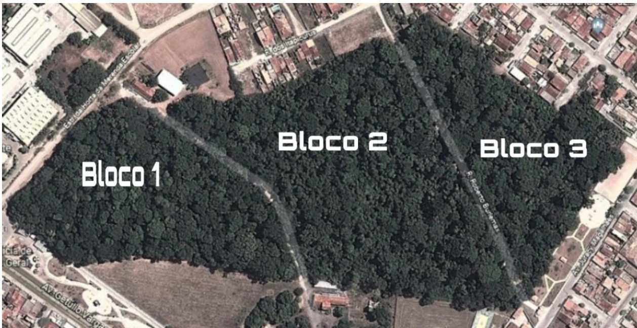
Figura 1: Vista aérea do Parque Florestal Mata de Cazuzinha. Fonte: Google Earth
