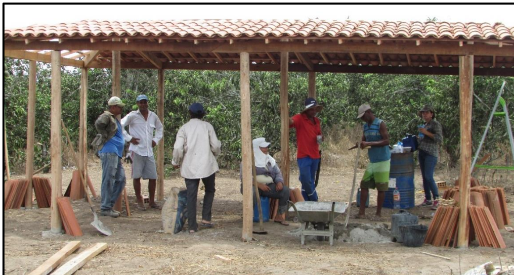
Figura 10. Mutirão na construção do Galinheiro
