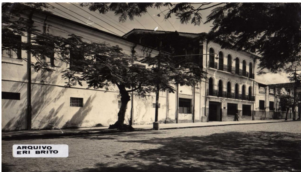
Foto do prédio Leite Alves, antes de ser reformado para a instalação do Centro de Artes, Humanidades e Letras (UFRB/CAHL).
