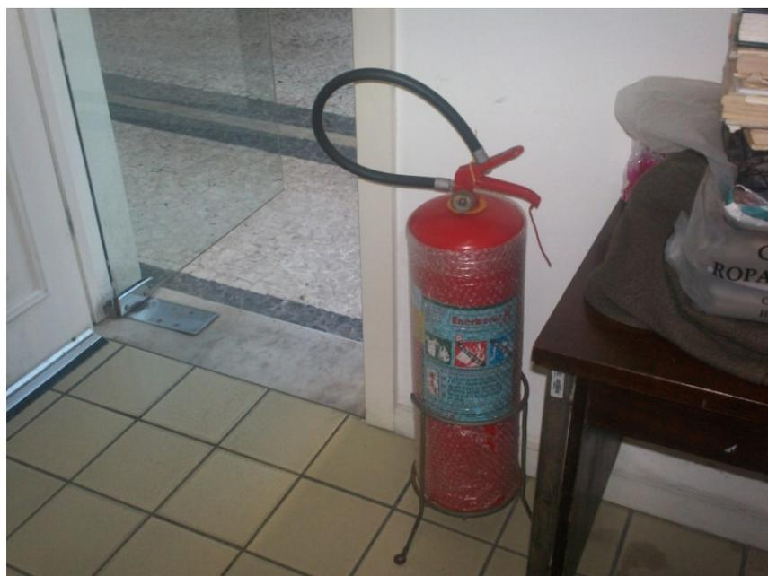
**Fig.22** Extintor do tipo A.
