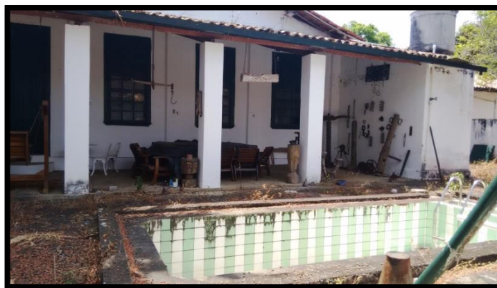
FIGURA 17: Vista interna da varanda lateral direita.
