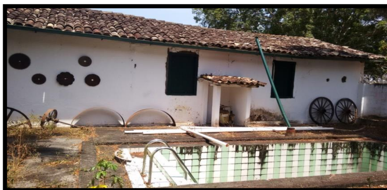
FIGURA 15: Vista interna do pátio, fachada lateral esquerda da casa do vaqueiro.
