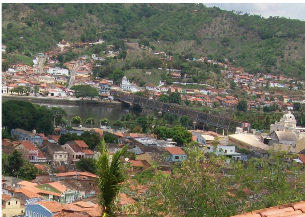
Fig. 7 – Seção 3 da fotografia atual. Autor: Gilcimar Barbosa, 2011.
