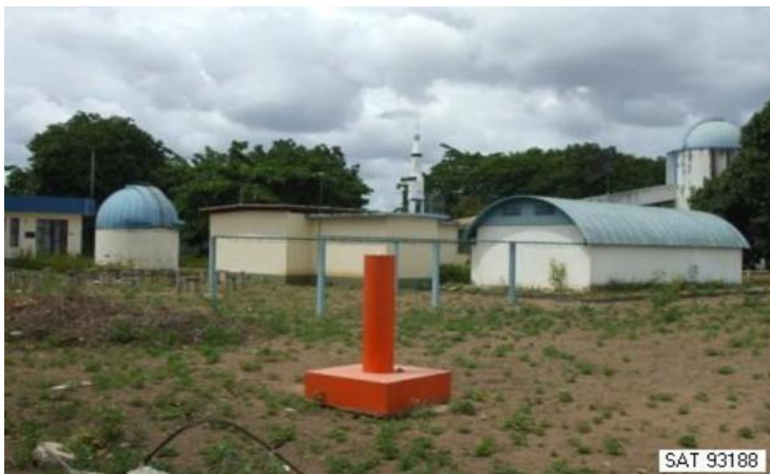
Figura 11 - Estação Base localizada no Observatório Antares. Fonte: IBGE.
