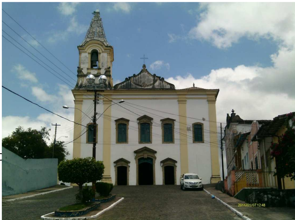
Figura 1 – Igreja de Nossa Senhora da Conceição do Monte (Cachoeira). 2011.
