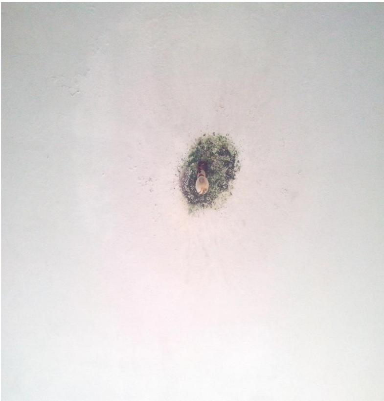
Figura 18: Problema de infiltração.
