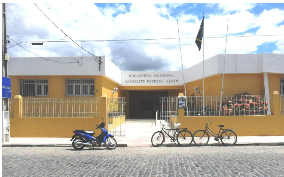
Figura 1: Fachada da Biblioteca Municipal Carmelito Barbosa Alves. Fonte: Autora, 2012.
