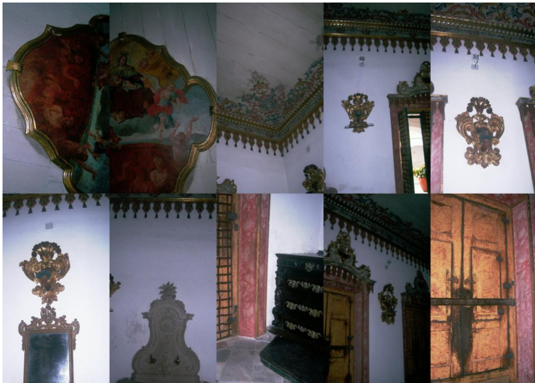
FIGURA 18- Estrutura da sacristia. Fonte: Autora, 2011.
