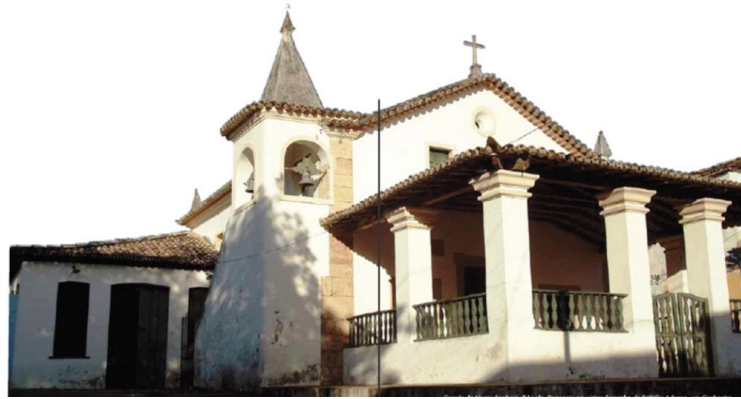
FIGURA 3- Capela pertencente ao antigo engenho da família Adorno, em Cachoeira. Fonte: Azevedo, 2009 p.112-113.
