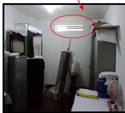
Figura 12- Entrada de iluminação natural e ventilação no interior da Reserva Técnica. Fonte: Autora, 2011.
